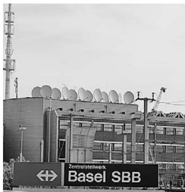
Die Anlage auf dem Swisscom-Gebäude an der Grosspeterstrasse verfügt über 13 grosse Offsetspiegel. Foto: zVg
