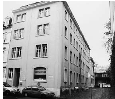
Das sich im Umbau befindliche Haus an der Reichensteinerstrasse 14.
