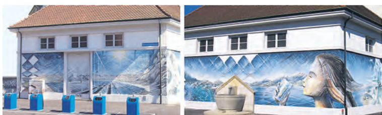
Das künstlerisch gestaltete Transformatorhäuschen an der Reinacherstrasse/Ecke Dornacherstrasse, mit farblich abgestimmten neuen Altglas-Sammelboxen. Fotos: Roli Baer
