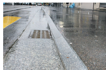
... 2: die abgeschrägten Kanten sind vor allem bei nassem Wetter sehr rutschig (Velountauglich!)...
