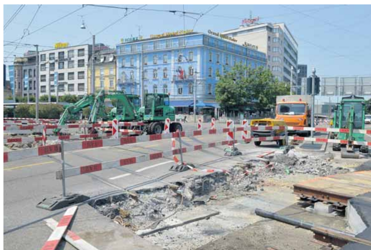
Die Realität: Baustellen-Momentaufnahme vom Bahnhofplatz/Aeschengraben: «Willkommen in Basel». Foto: J. Zimmermann
