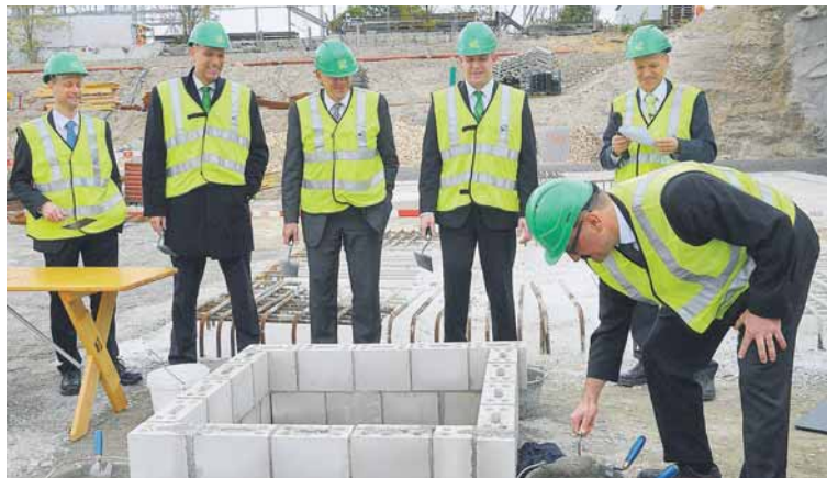
Grundsteinlegung der BVB Neubauten.
