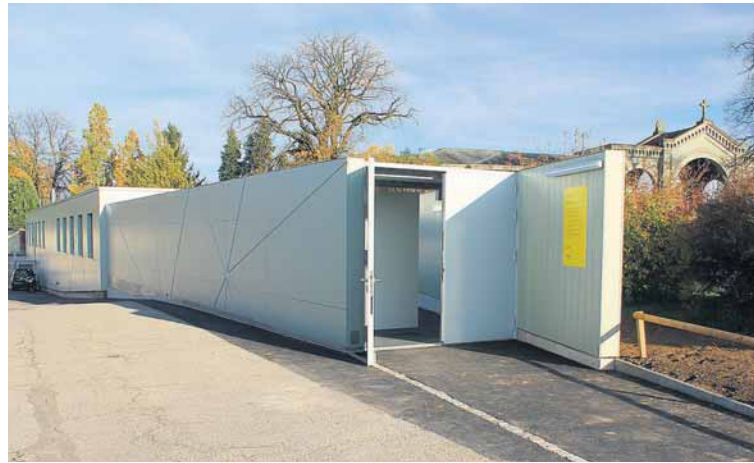
Das neue «K+A Dreispitz» (früher auch Spritzehüsli oder Gassenzimmer genannt) neben dem Friedhof Wolfgottesacker. Dass ca. 2,6 Mio. Franken teure Zweckgebäude stört den denkmalgeschützte Wolfgottes-Eingang. Wo war hier die Stadtbildkommission? Foto: GZ.
