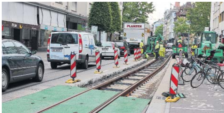
Eine der vielen, vielen Baustellen inklusive Verkehrs-Chaos: Gleiserneuerungen in der «Boulevard-Gepfusch» Güterstrasse. Foto: GZ
