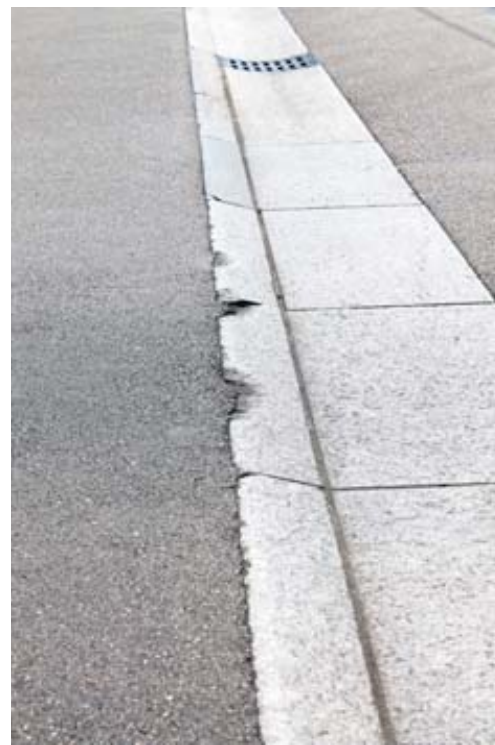
Der Marmor bröckelt überall in der «Couloir Güterstrasse» - sehr gefährlich nicht nur für Velofahrer.
