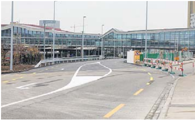
Die Trottoirführung wird an der neu verlegten Meret Oppenheim-Strasse ohne jegliche Vorsegnalung abrupt beendet. Das führt zu gefährlichen Situationen für die vielen Fussgänger, die sich orientierungslos auf dem Velostreifen Richtung Bahnhofzugang respektive dem «Busbahnhof» zu bewegen.
