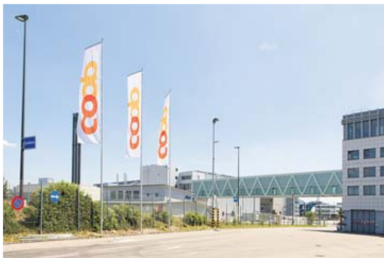
Das neue Coop-Logistikzentrum in Schafisheim.
