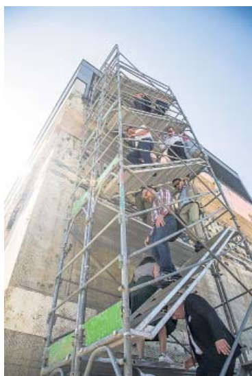
Die Grundsteinlege-Teilnehmerinnen und -nehmer, unterwegs zum tiefsten Punkt der MOH-Baugrube.
