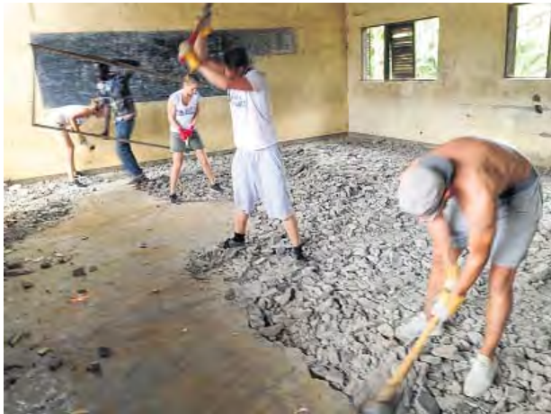
Schwerer Körper-einsatz des Basler «Give a Chance»-Teams beim Umbau einer Grundschule in Kribi (Kamerun). Foto: zVg
