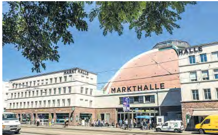
Ein zu neuem Leben erweckten gastronomisch-kulturellen Begegnungsort an der Schnittstelle zur Innenstadt.
