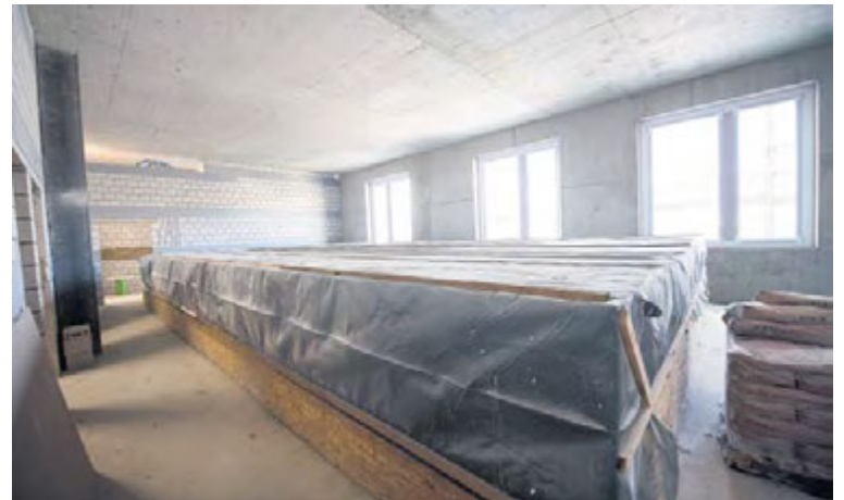
Hier im Parterre entsteht das Therapie-Schwimmbaden.
