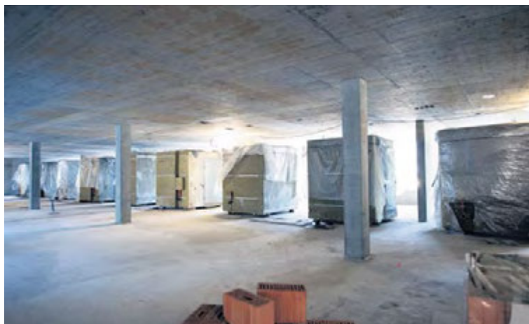
Die Nasszellen-Elemente stehen bereit zur Installation.
