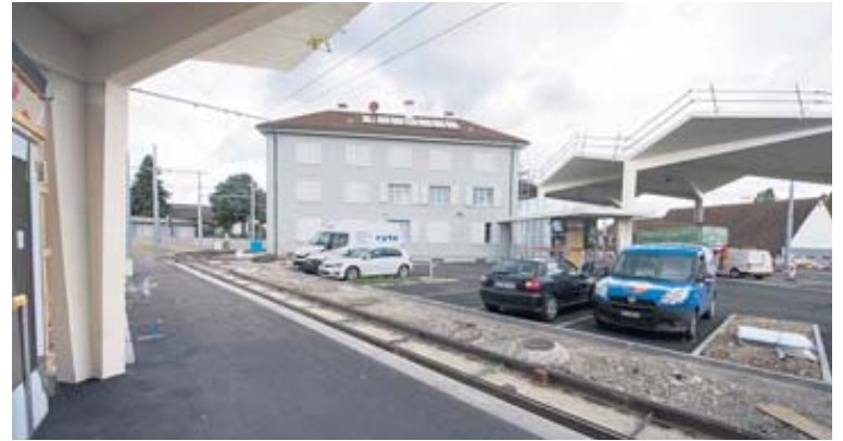
Die neue Zollstation vom Wartehaus an der Tramhaltestelle aus gesehen. In diesem Haus hat es auch eine Zone für die Chauffeuren und Chauffeure, inklusive Dusche und Kaffeemaschine und auch die Technik ist hier untergebracht. Vorne neben dem blauen Haus die Abfertigungshalle für die Mehrwertsteuerverrechnung.
