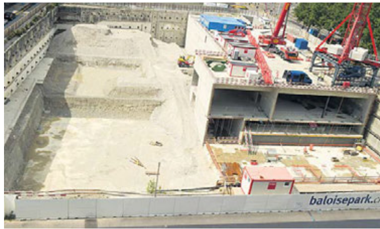
Die Sockelgeschosse des zukünftigen Hotelturms sind im Rohbau bereit fertig erstellt. Im Untergrund wird ein Ball- und Bankettsaal installiert als neuestes Basler Eventzentrum.
