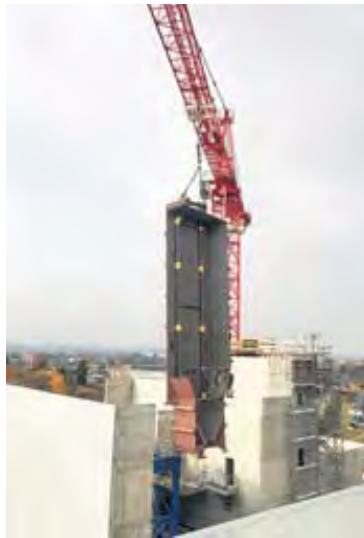
Ein Teil des Dampfkessels für das neue Holzkraftwerk wird eingebaut.
