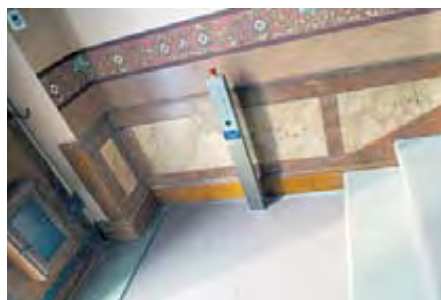
Bei allen Treppen hat es dezent angebrachte Behindertenhebebühnen.
