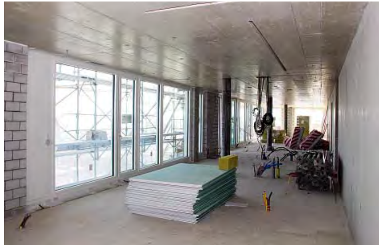
Auch in der sich noch im Rohzustand befindlichen Penthouse-Wohnung muss sich der künftige Mieter mit den Betonpfeilern (im Hintergrund) auseinandersetzen.
