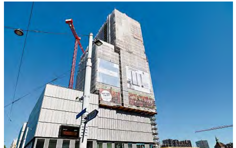
Der Turm im aktuellen Rohzustand: Höhe erreicht.
