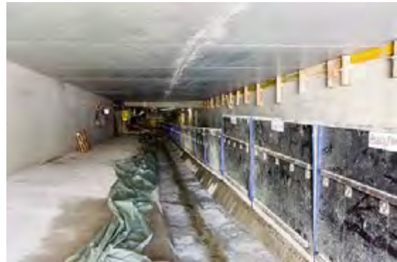
Der vordere Teil der Eindohlung musste ausgebaut werden.
