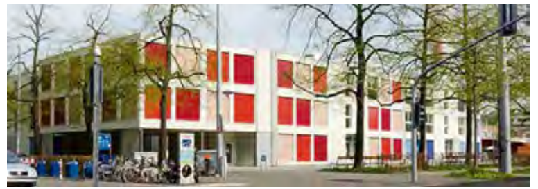
Das Provisorium auf der Voltamatte.
