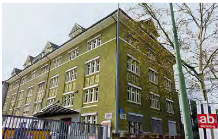
Die Coop Verteilzentrale soll zum Schulhaus werden. Fotos: Philip Karger
