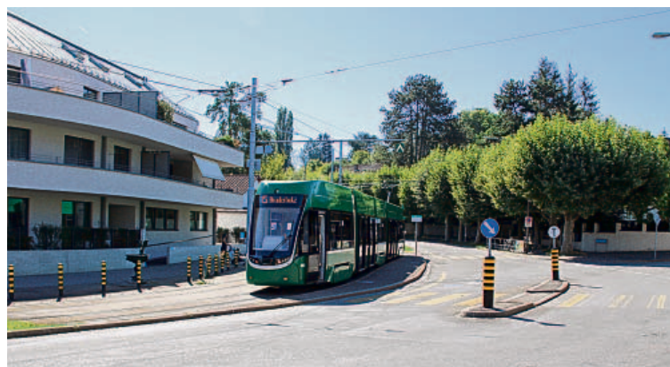
So wird u.a. die Haltestelle «Studio Basel» auf 33 Metern begradigt und die Gleise näher zum Haus verschoben. Fotos: Thomas P. Weber
