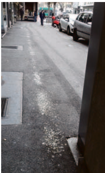
In der ganzen Güterstrasse sind Taubenkotrückstände sichtbar. Foto: zVg
