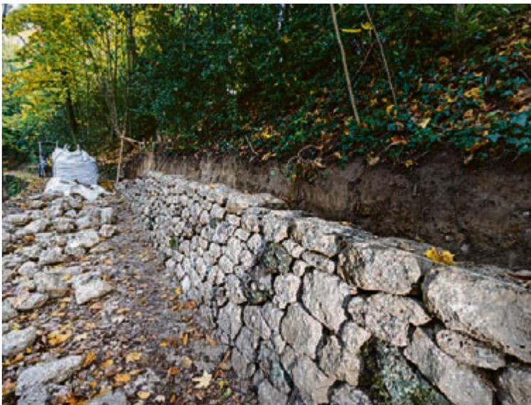
Sanierung der alten Nagelfluhmauer in Trockenmauer-Bauweise.
