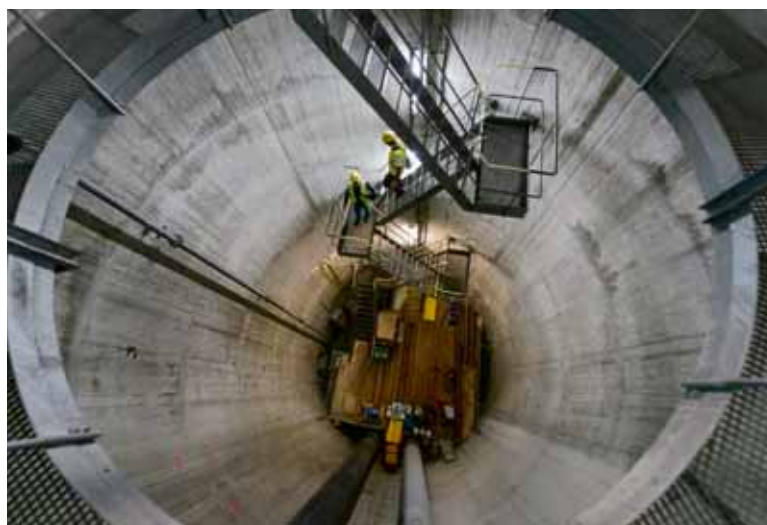
Der Abstieg in den Energieleitungstunnel Wolf erfolgt über 120 Treppenstufen steil nach unten.
