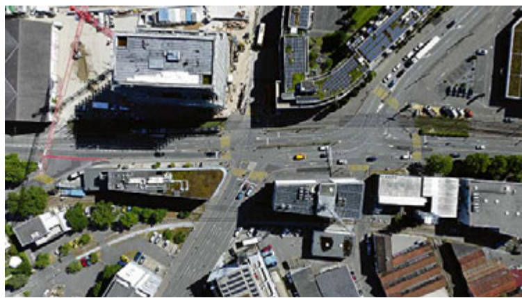
Luftaufnahme vom «Dreispitzknoten».
