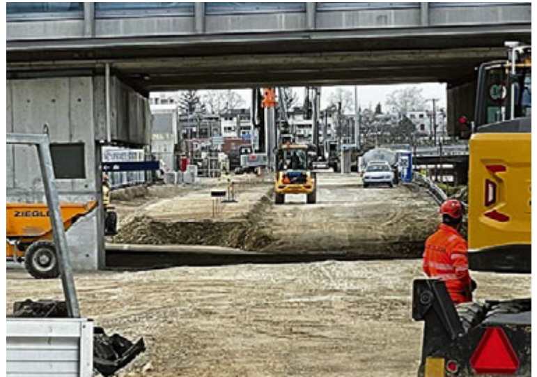
SBB-Grossbaustelle MO-Strasse mit gigantischen lauten Bohrern.
