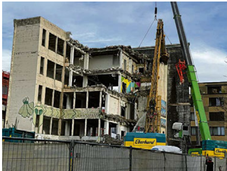
Rückbau: Hier wird Platz gemacht für die geplanten Nauentor-Hochhäuser.
