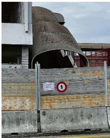
Seit neuestem ist jetzt auch der Bhf-Zugang zur Postpasserelle geschlossen. Als Alternative besteht nur noch die bereits jetzt schon überfüllte Bahnhofs-Passerelle.
