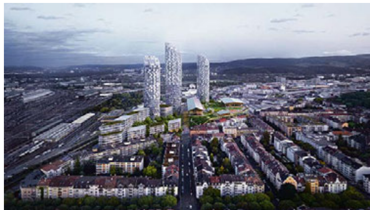
Vision Dreispitz Nord, mit den drei markanten Hochhäusern. Unten gut erkennbar die Güterstrasse.
