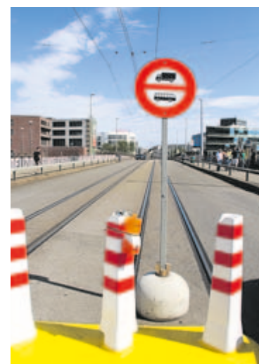
Die Margarethenbrücke bleibt noch lange für den ÖV sowie Lastwagen, Busse und auch grosse Feuerwehrfahrzeuge gesperrt!
