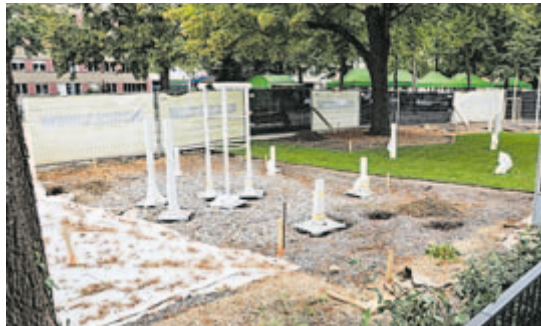
Der Kinderspielplatz wartet noch auf seine Fertigstellung.
